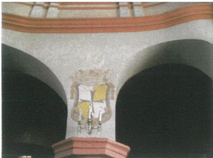
F36. Zondaže z.115,116 atidengtas baroko laikotarpio konsekracinio kryžiaus fragmentas. Aukščiau zonuotas vargonų choro karnizas, Turėklo architektūrinės detalės z.117,118-121.
